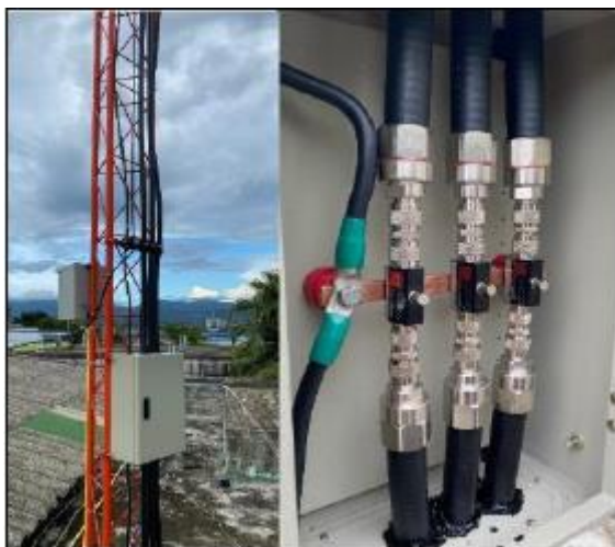
ภาพ 6 การประสานสายนำสัญญาณเข้ากับเสาวิทยุคมนาคม และการติดตั้งกับดักฟ้าผ่า (Lightning Arrester) ของสายนำสัญญาณ
