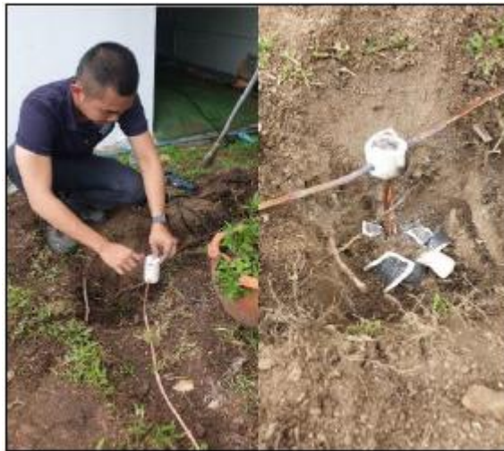
ภาพ 8 การเชื่อมต่อสายตัวนำกับระบบรากสายดิน โดยการเชื่อมด้วยความร้อน (Exothermic Welding)
