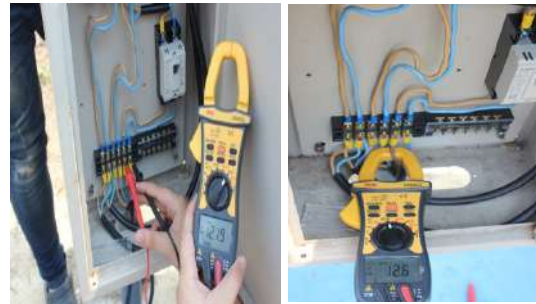
รูปที่ 6 การวัดกระแสและแรงดันขั้วมอเตอร์
