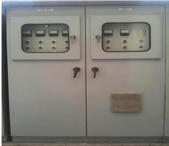
รูปที่ 9 ตู้ที่ใช้ในการติดตั้ง VSD
