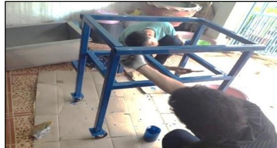
รูปที่ 5 ประกอบโครงสร้างเพื่อติดตั้งชุดอุปกรณ์ระบบนิวแมติกส์
