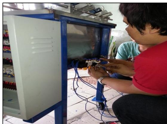
รูปที่ 7 ติดตั้งชุดโซลินอยด์วาล์ว เติมน้ำมันไฟฟ้าและวางจอร์นิวแมติกส์
