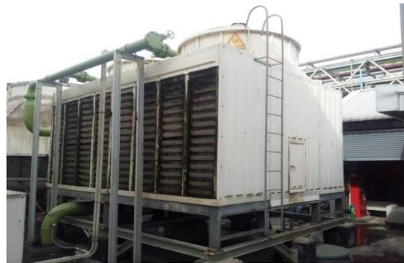
รูปที่ 4 หอระบายความร้อนที่ใช้ในการทดลอง
