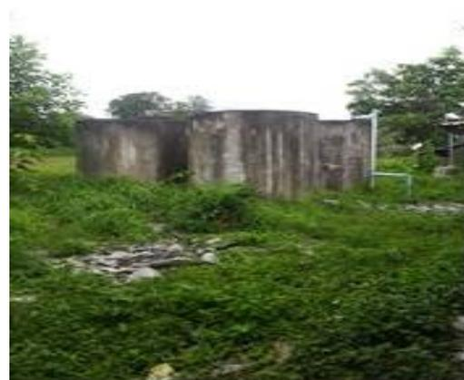
รูปที่ 7 ถังเก็บน้ำขนาด 40,000 ลิตรที่ใช้งานจริง
