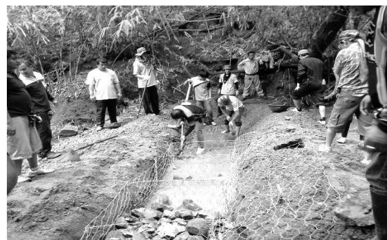
รูปที่ 3 สมาชิกร่วมมือร่วมใจสร้างฝายชลอน้ำ
