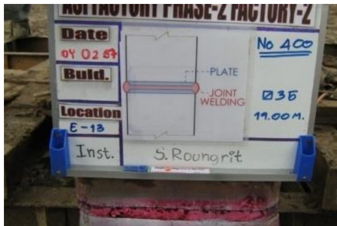
ภาพที่ 12 การตรวจสอบรอยต่อเชื่อมของเสาเข็ม
