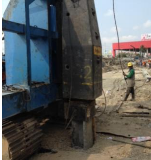
ภาพที่ 11 วิธีการใช้สลิงในการป้องกันการยกลูกตุ้มน้ำหนักเกินกำหนด
