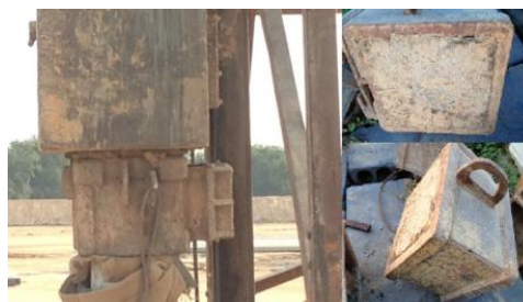
ภาพที่ 10 สภาพการตอกโดยใช้ไม้ชะมแบบแผ่นเต็มหน้าตัด
