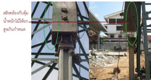
ภาพที่ 8 การใช้สลิงคล้องลูกตุ้มน้ำหนักเพื่อป้องกันการยกเกินระยะที่กำหนด
