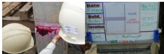
ภาพที่ 9 การทดสอบรอยเชื่อมและถ่ายรูปตรวจสอบรอยเชื่อม
