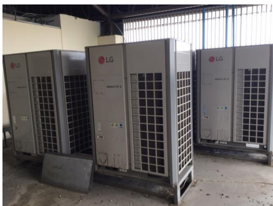
ภาพ 1 เครื่องปรับอากาศแบบน้ำยาแปรผัน ยี่ห้อ LG Model : MULTI V5
