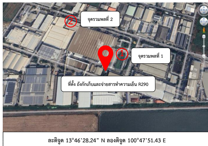
ภาพ 1 แสดงตำแหน่งที่ตั้งถังเก็บและจ่ายสารทำความเย็น R290 และจุดรวมพล
